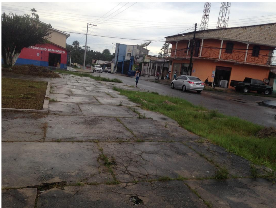
CALÇADA – RUA DO LEANDRO PINHEIRO
