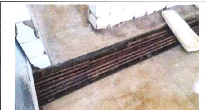
Foto 05: Ferragem oxidada
