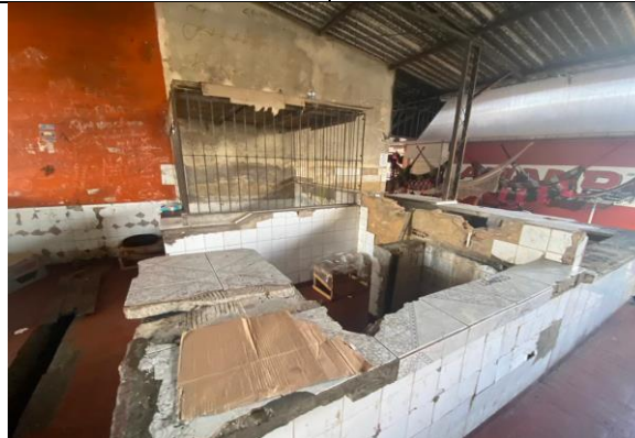
Foto 03: Revestimentos quebrados
