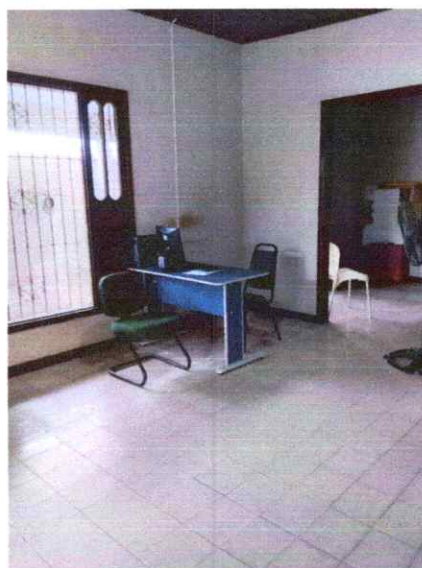
Imagem 05: Recepção e circulação interna.
