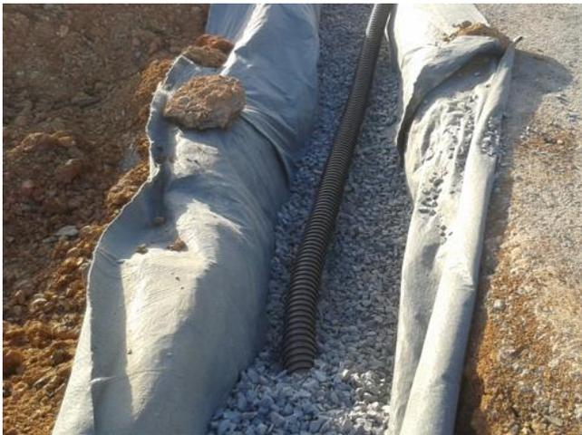
Após feito o enchimento com brita fecha-se a parte superior do dreno com a manta geotêxtil, inclusive com trespasse entre as abas.
