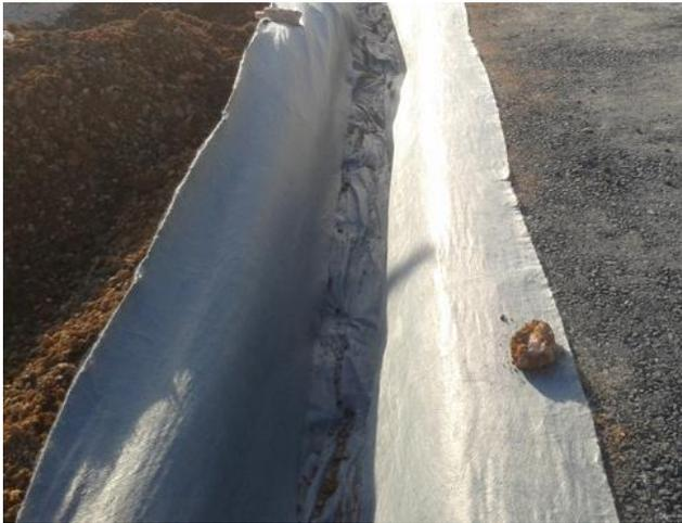
A brita 19mm (brita 01) deve ser colocada no fundo formando uma camada de 10cm ao longo de toda a vala. Em seguida coloca-se o tubo dreno perfurado e completa-se toda a vala com brita, fechando toda a vala.
